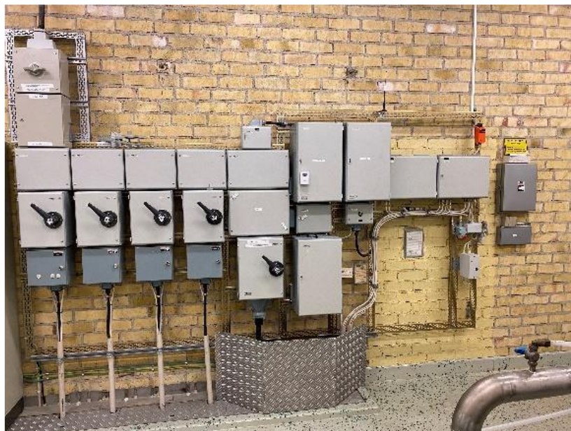
Figur 1. Nybohov vattenpumpstations ställverk från 1996.
